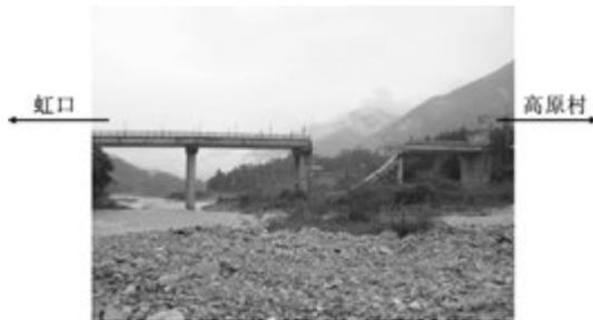
图 2 高原大桥落梁震害
